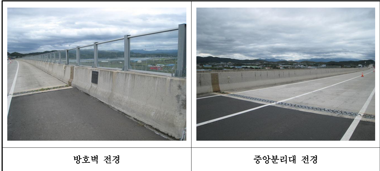
【사진 33.3.23】 방호벽 및 중앙분리대 전경
