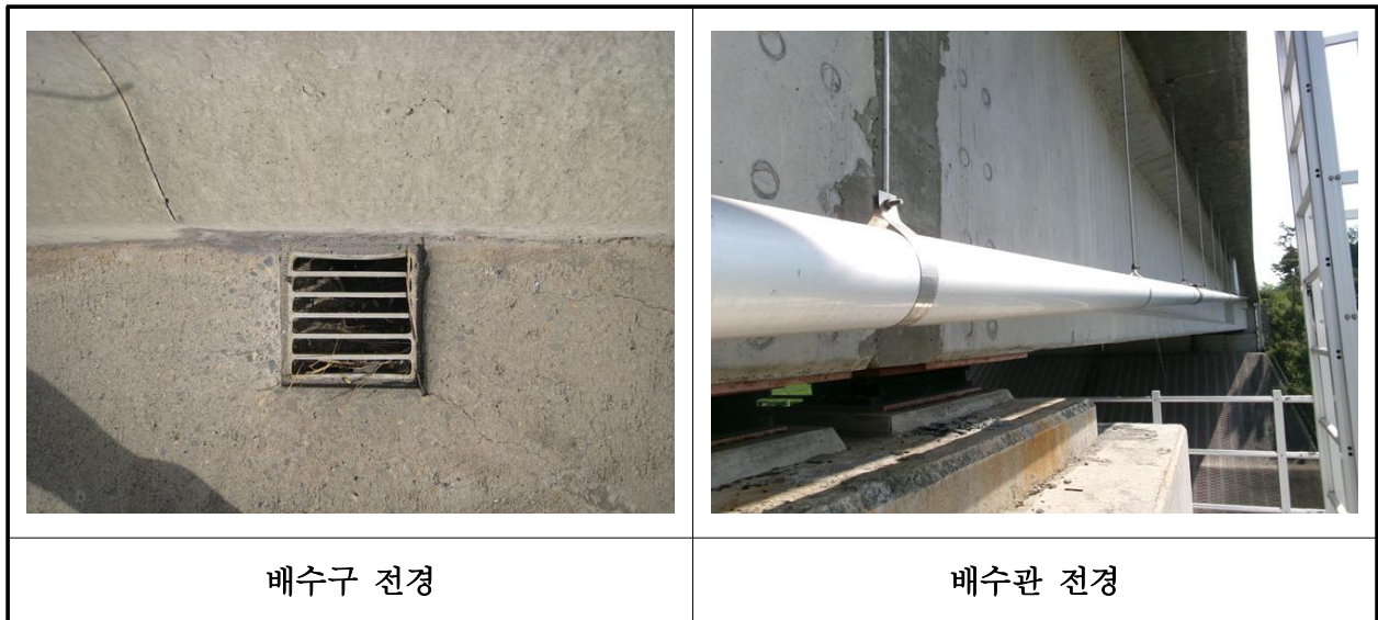
【사진 33.3.21】 배수시설 전경
