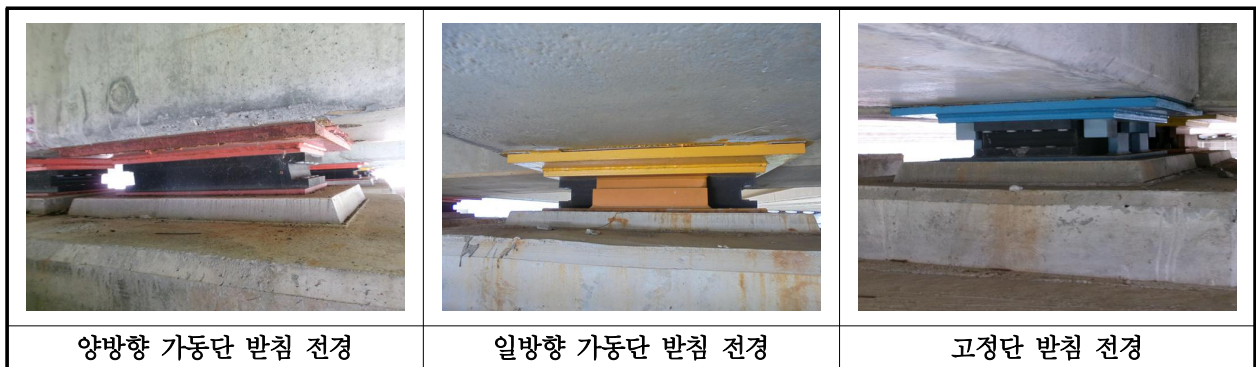
【사진 33.3.12】 교량반침 전경
