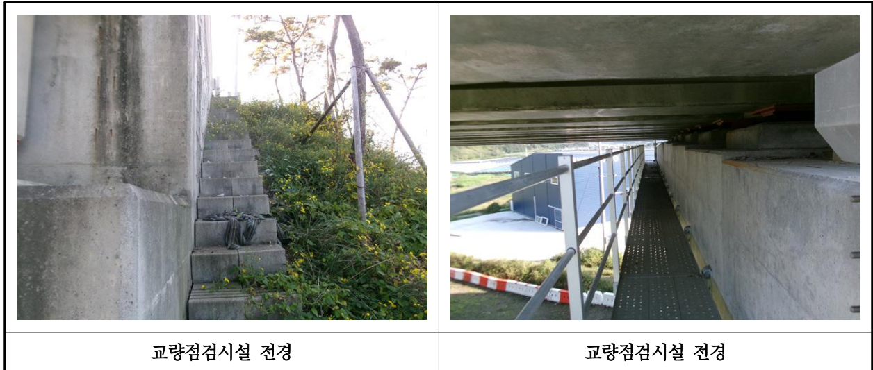
【사진 33.3.25】 교량 점검시설 전경
