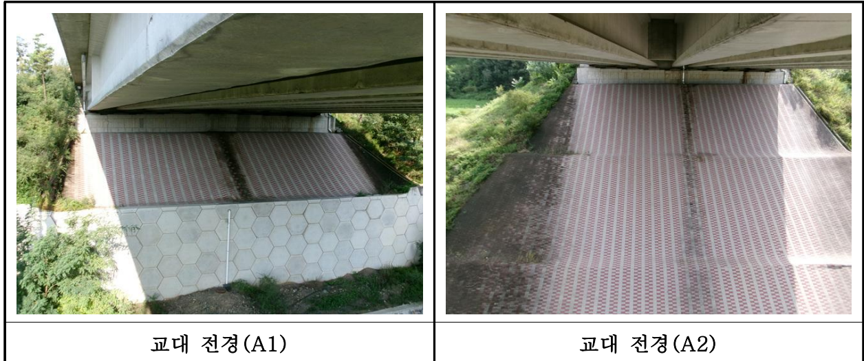
【사진 33.3.8】 교대 전경
