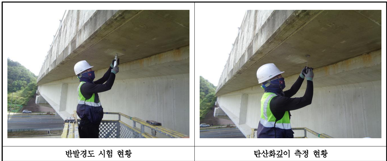
【사진 33.4.1】 콘크리트 내구성조사 현황
