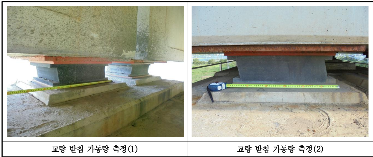
【사진 33.3.15】 교량받침 이동량 측정
